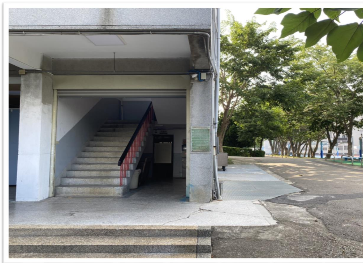
體溫量測站--位於教學大樓(2)北側樓梯入口(✓)
