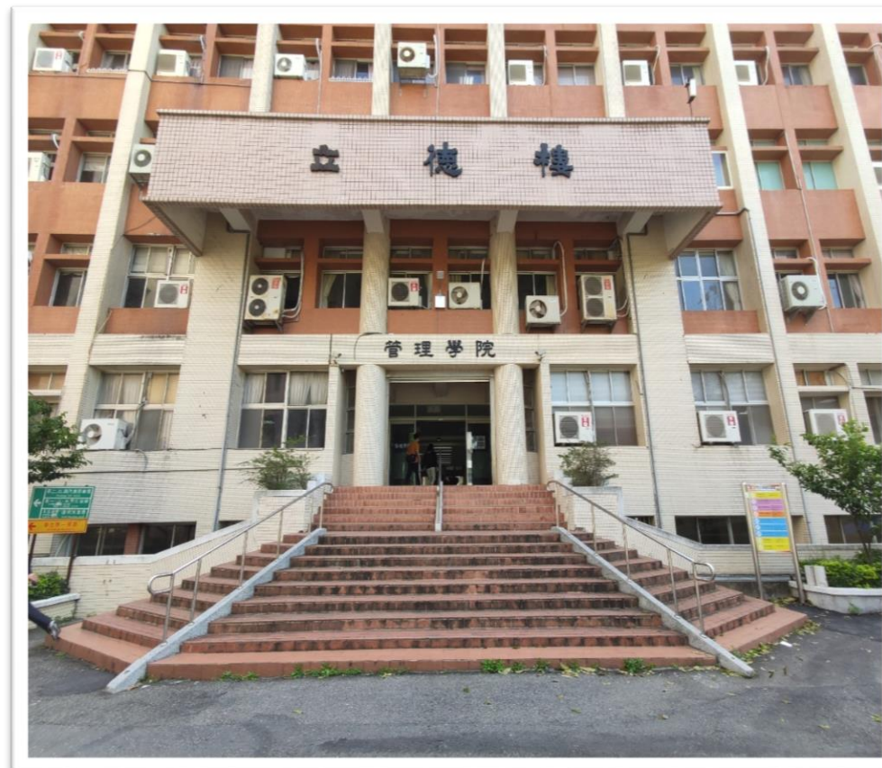
體溫量測站--位於立德樓一樓正門(✓)
