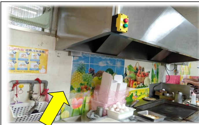
爐灶台牆面使用花色之貼紙貼牆壁
