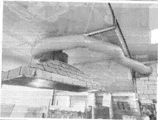
天花板之不用抽油煙罩應撤除避免藏污納垢及病媒躲藏之處所，造成污染食材之源頭。
