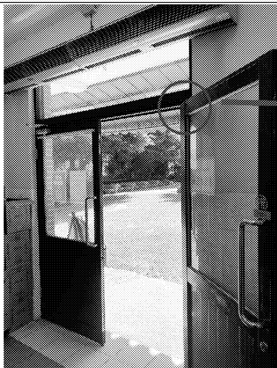
【圖十一】大門右側門弓器損壞，於大門關閉後，開啟抽風機時，因壓力關係導致大門無法緊閉，易使病媒(老鼠)入侵。
