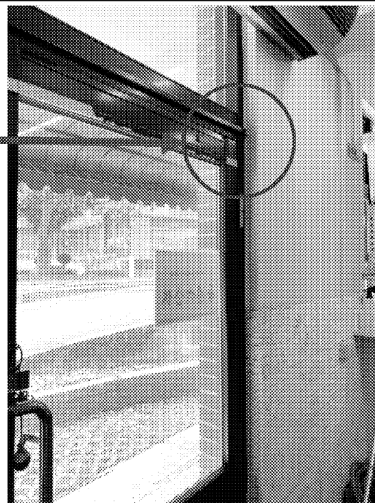
【圖十一】大門右側門弓器損壞，於大門關閉後，開啟抽風機時，因壓力關係導致大門無法緊閉，易使病媒(老鼠)入侵。
