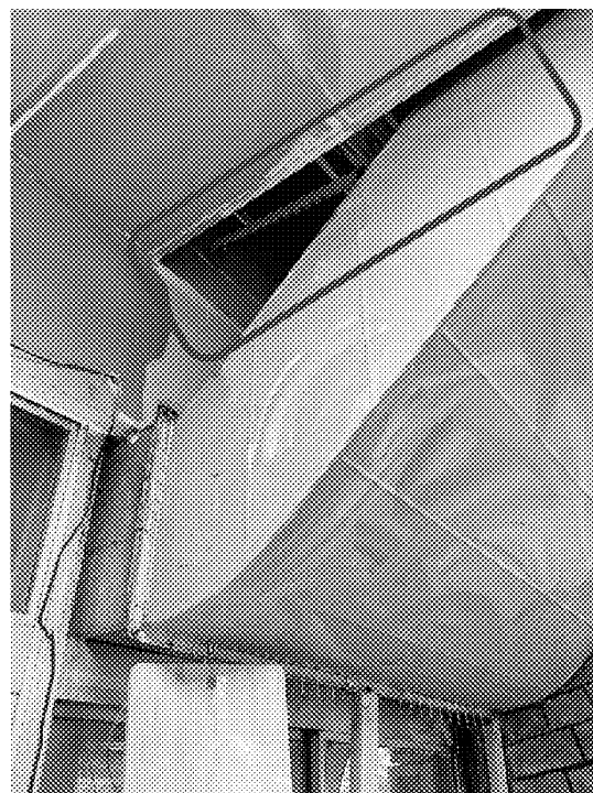
【圖十】抽油機附近天花板多處孔洞，易藏匿病媒
